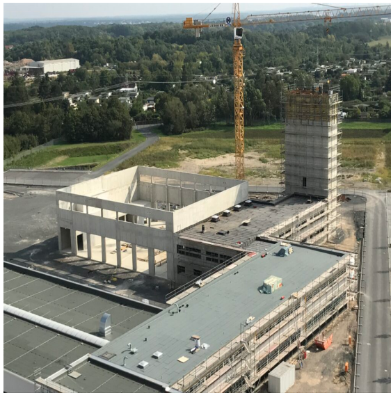
Neubau eines Verwaltungsgebäudes sowie einer Werkhalle inkl. einem Übungsturm
