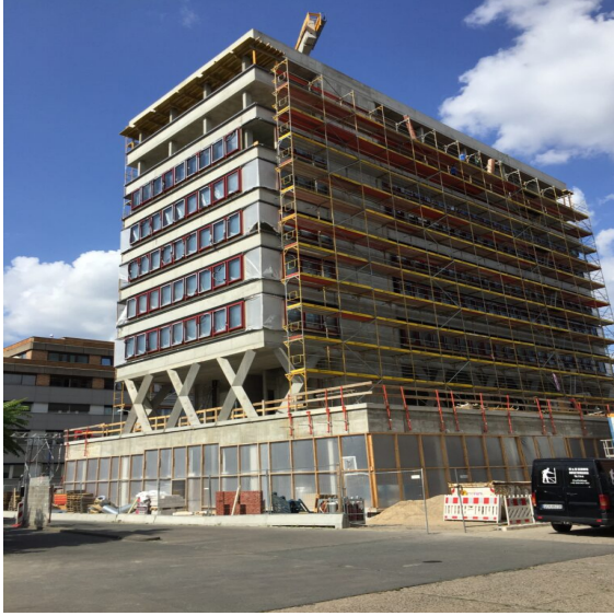
Neubau eines 8-geschossigen Bürogebäudes in Berlin am Ostbahnhof
